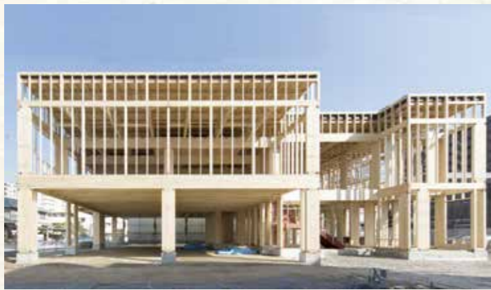
木材利用促進法とともに需要拡大が進む中・大規模木造建築。 同社は企業オフィスや保育園などの構造躯体も手掛けている
